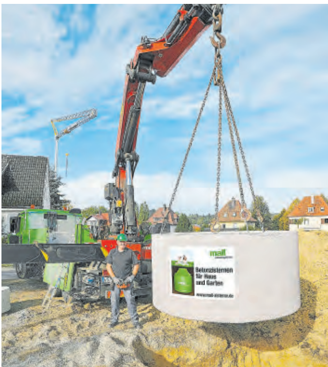
Eine unterirdische Zisterne wird geliefert - einfach und schnell direkt vom Lieferfahrzeug. Foto: DJD/Mall
